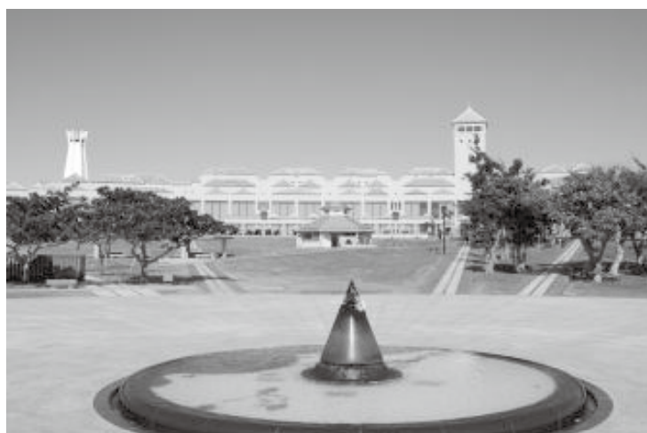
沖縄県平和祈念資料館外観
