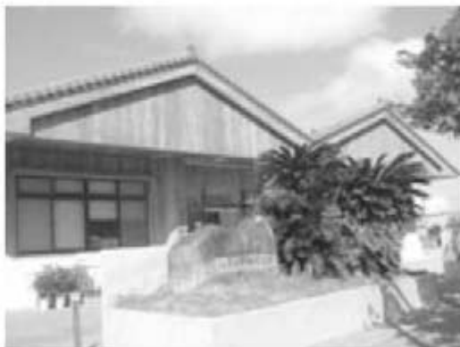
八重山平和祈念館外観
