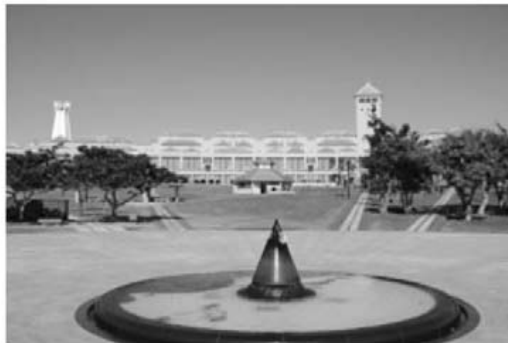
沖縄県平和祈念資料館外観
