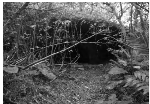
茂みの中に1基残った掩体壕
