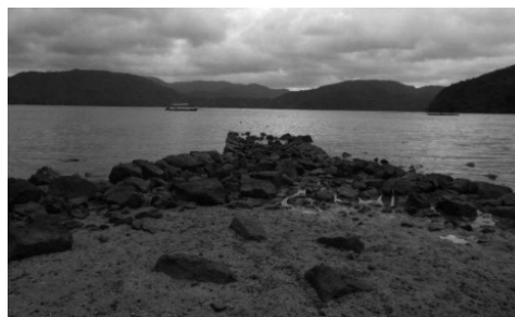
石積みが残る海軍棧橋跡
