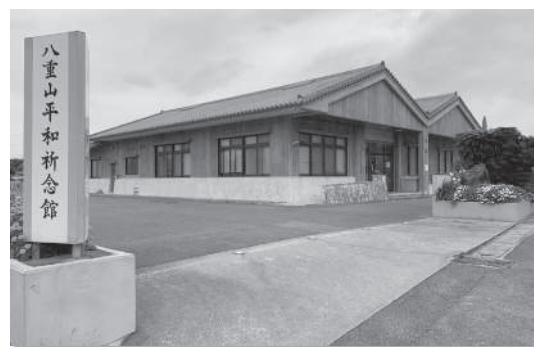
八重山平和祈念館外観
